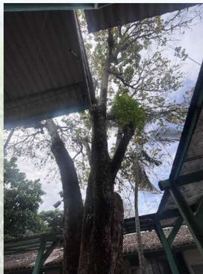
Fotografía 3. Estado inicial y condiciones de emplazamiento de los árboles antes de la intervención.
