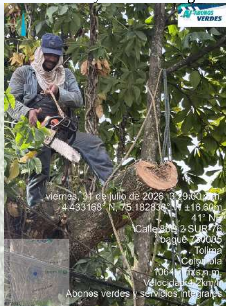
Fotografía 17. Proceso de tala controlada y descenso dirigido de ramas y secciones de fuste.
