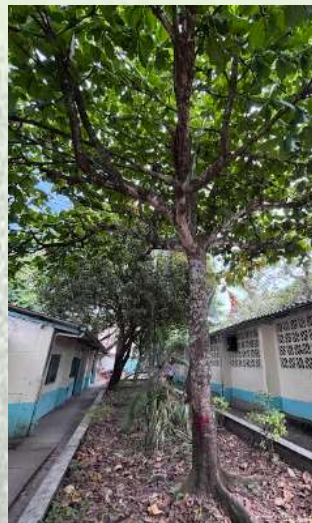
Fotografía 5. Estado inicial y condiciones de emplazamiento de los árboles antes de la intervención.
